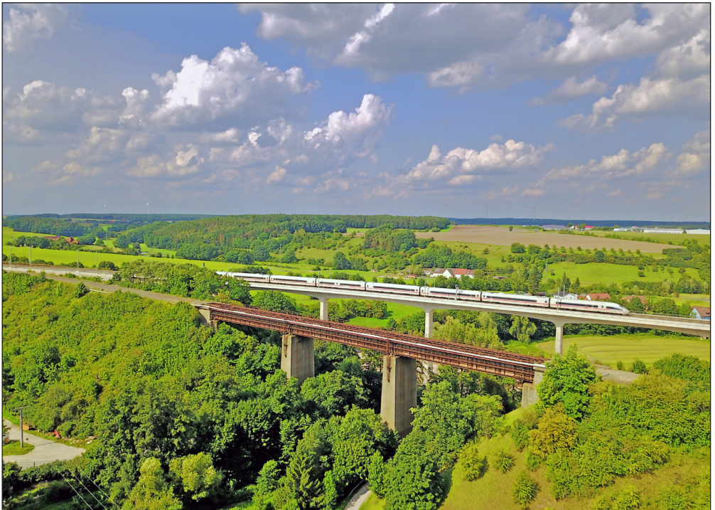
Kurz vor dem Abriss der alten Brücke gelang Bertram Rupprecht diese eindrucksvolle Aufnahme der beiden Aurachtalbrücken einträchtig nebeneinander. Gut erkennbar ist hier auch die Änderung der Trassenführung.
