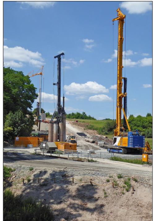
Bei den Gründungsarbeiten für die neuen Pfeiler konnte Volker Kabisch schweres Gerät beobachten.
