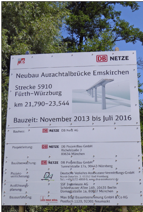
Die Eckdaten zur Baustelle fanden sich auf der von Volker Kabisch verewigten Bautafel.
