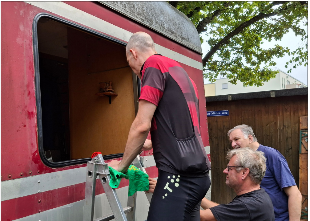
Die anderen drei handelnden Personen, PD Dr.-Ing. habil. Sebastian Pfaller, Peter Schulz und Bernhard Mrugalla (von links), wurden hier beim Einpassen der neuen Fensterdichtung verewigt. Fotos (2). Michael Mrugalla
